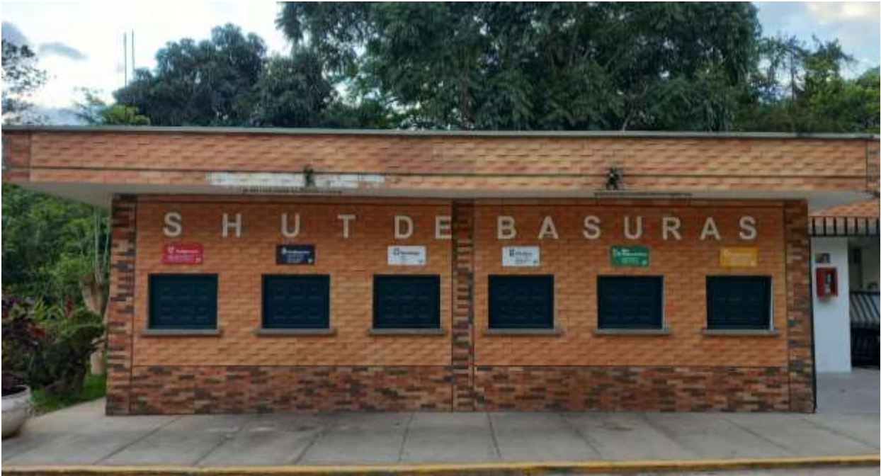
Figura 7. Área de almacenamiento y clasificación de residuos - Shut de Basuras
