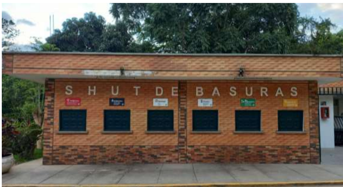
Figura 6. Área de almacenamiento y clasificación de residuos - Shut de Basuras
