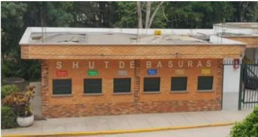
Figura 7. Área de almacenamiento y clasificación de residuos - Shut de Basuras
